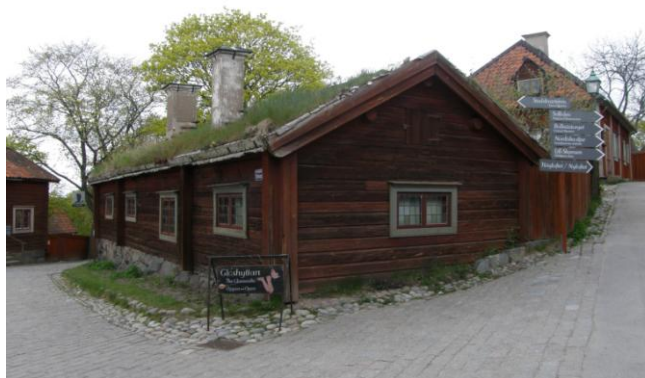
Fot. 1. Zielony dach na pochyłym dachu budynku historycznego
