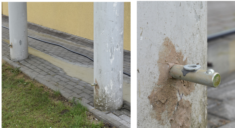
Rys. 5. Repery posadowienie na badanych słupach (po lewej) oraz stabilizacja repera nr 10 (po prawej)
