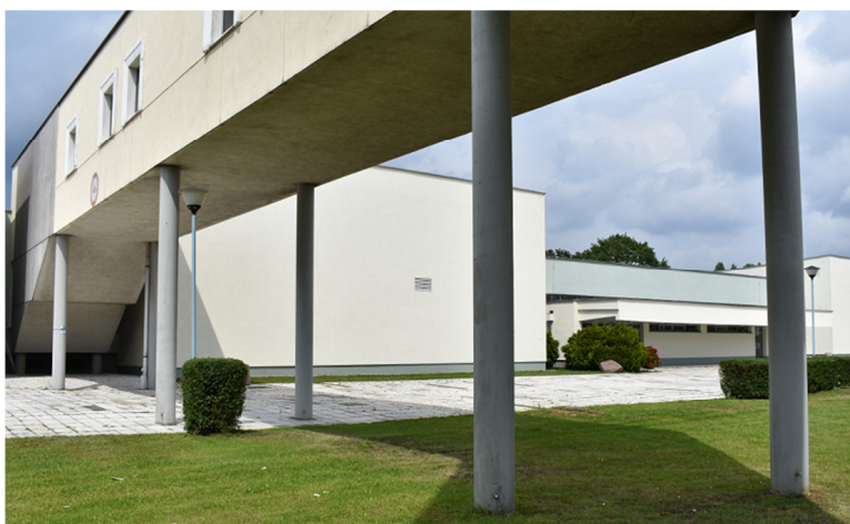
Rys. 2. Widok ogólny łącznika od strony Auditorium Novum
