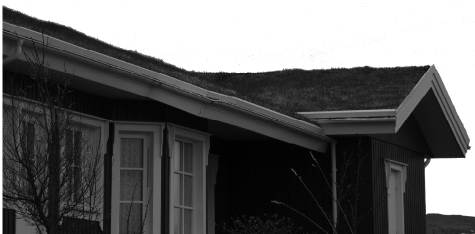
Rys. 2. Budynek z zielonym dachem - Sólheimar Ecovillage - fot. Autor
