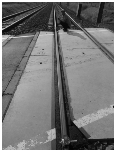
Rys. 9. Pomiar długości płyt przejazdowych z użycie MMS z tarczą pomiarową (fotografia własna)
