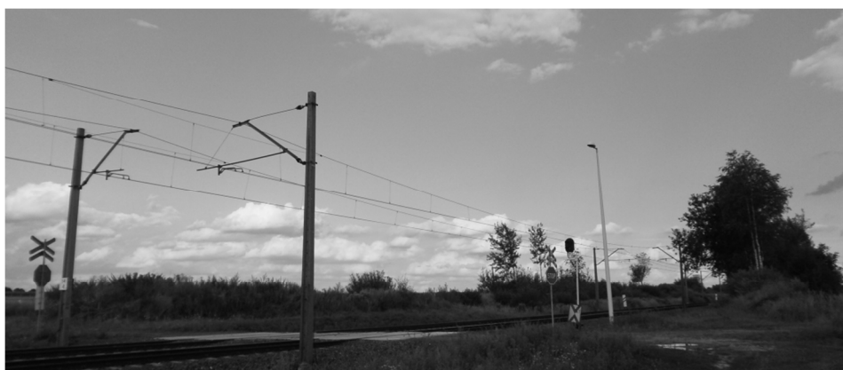
Rys. 5. Przejazd kolejowo-drogowy kategorii D (fotografia własna)
