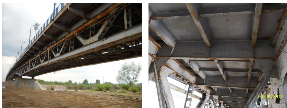
Rys. 2. Most przez Wisłę w Sandomierzu oraz elementy jego pomostu
