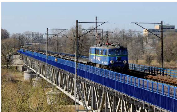
Rys. 3. Widok ogólny mostu
