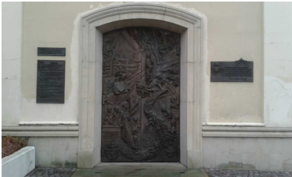
Rys. 1. Zachodnia elewacja wieży, fot. autor, październik 2016
