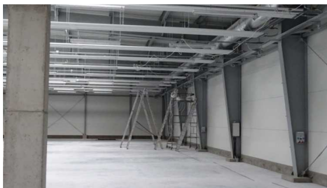
Rys. 3. Instalowanie podsufitowych promienników w trakcie robót
