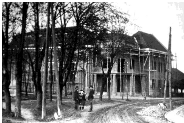
Rys. 13. Widok „Sokoła” w Sieniawie od strony południowej w pierwszej ćwierci XX wieku w trakcie prac budowlanych, Archiwum IHAIKZ WA PK, s.v.
