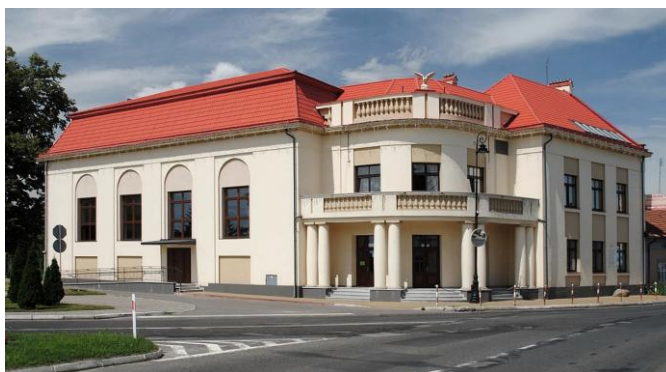
Rys. 18. Widok ogólny „Sokoła” w Sieniawie od strony południowej po interwencji konserwatorskiej, fot. D. Kuśnierz-Krupa, 2009
