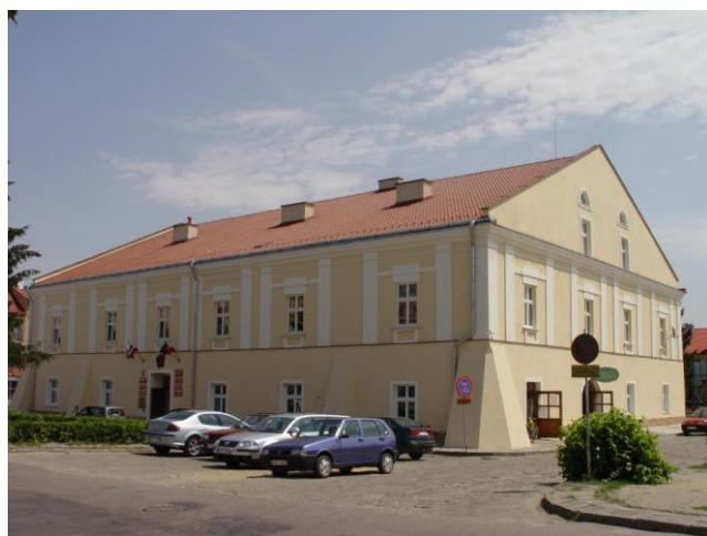
Rys. 6. Sieniawa – ratusz od strony południowo-zachodniej przed interwencją konserwatorską, fot. D. Kuśnierz-Krupa, 2005
