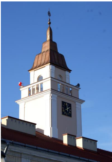
Rys. 10. Sieniawa – widok na wieżę ratusza od strony południowo-wschodniej po interwencji konserwatorskiej, fot. D. Kuśnierz-Krupa, 2012
