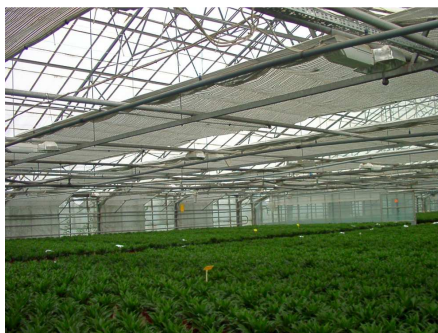
Rys. 1. Ekran termooizolacyjny HS 787 w szklarni Fig. 1. Thermal screen type HS 787 inside greenhouse
