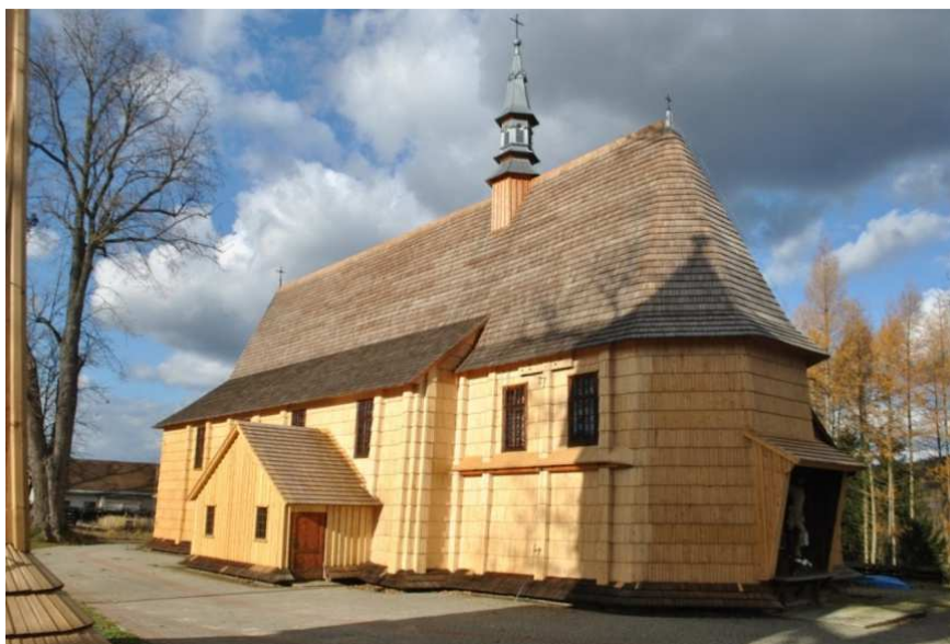
Rys. 9. Widok kościoła po remoncie, strona południowo – wschodnia, 2015, fot. Ł. Gołda
