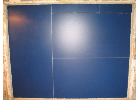
Rys. 6. Ściana z ociepleniem w technologii lekkiej suchej podczas badań laboratoryjnych, na podstawie [7]
