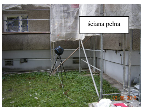
Rys. 3. Źródło dźwięku przy badanej ścianie pełnej przed dociepleniem
