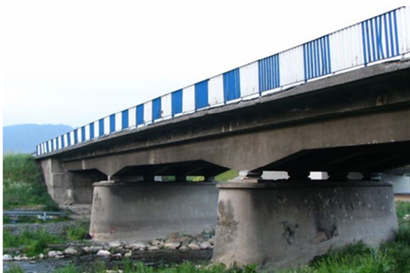
Rys. 1. Widok ogólny analizowanego mostu drogowego
