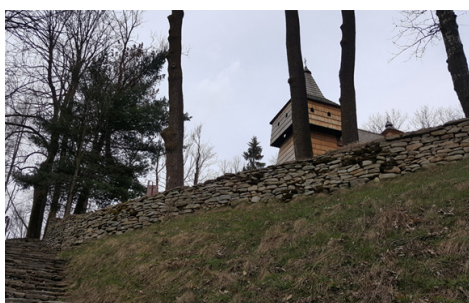
Ryc. 5. Kościół pw. św. Marcina w Grywałdzie. Widok od południa na fragment muru ogrodzeniowego oraz schodów terenowych. Fot. D. Kuśnierz-Krupa, 03.2016
