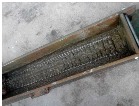
Rys. 1. Siatka zbrojeniowa układana w formie
