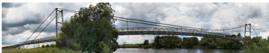
Rys. 1. Widok mostu od strony wody górnej
