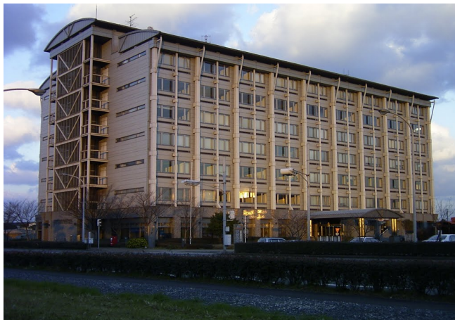
Rys. 2. Budynek urzędu pocztowego „Tobata Tobihata” w Kitakyushu z ramową konstrukcją nośną wykonaną ze stali FRS i wysuniętą poza obrys elewacji obiektu (opis budynku zamieszczono w [9], zdjęcie ze strony internetowej [11]).
