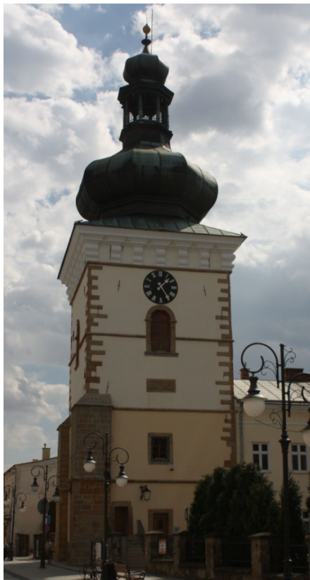
Fig. 1. North façade of the bell tower Rys. 1 Północna fasada wieży dzwonnicy
