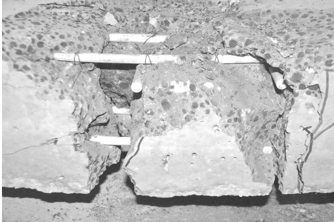
Rys. 19. Kontrola przyczepności prętów po lokalnym usunięciu betonu Fig. 19. Rebars bond control after local concrete removing
