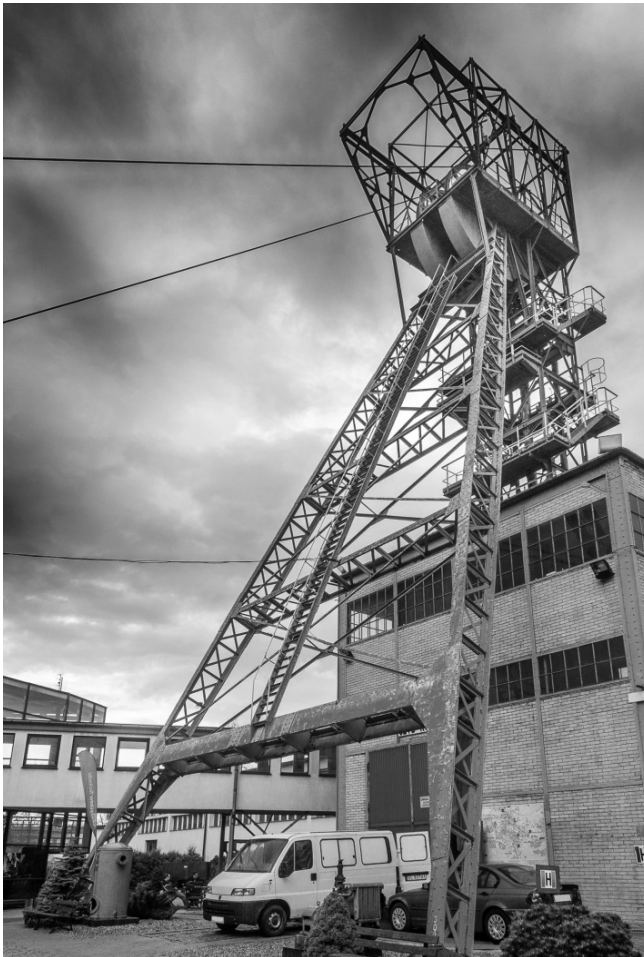
Rys. 1. Nadszybie szybu „Kolejowy” (fot.: E. Maciejowska-Figiel)
