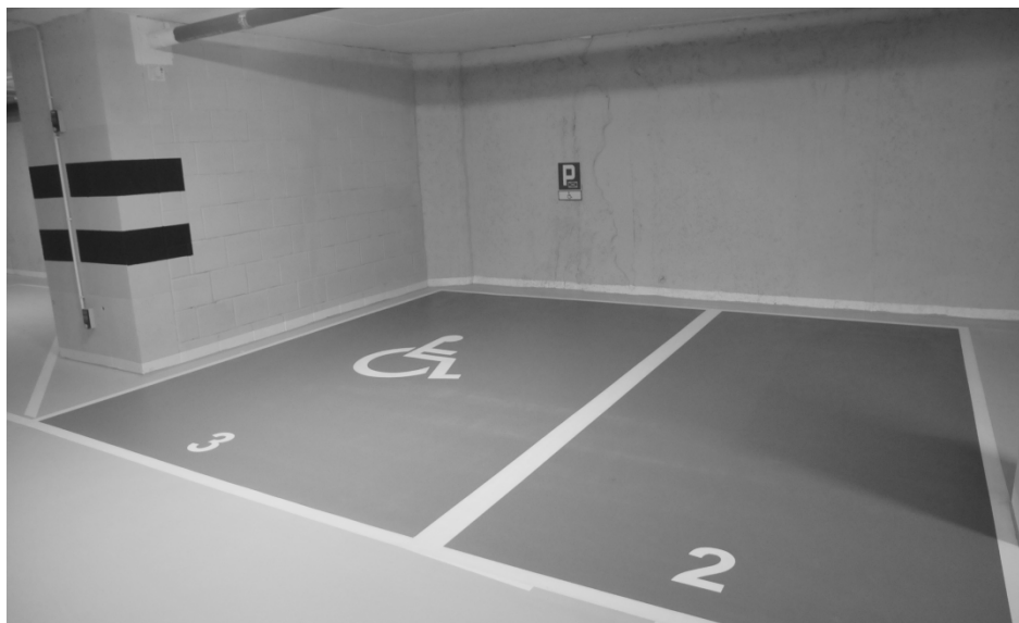
Rys.3. Miejsca postojowe dla osób niepełnosprawnych w garażu podziemnym wykonanym przy rewitalizacji Hotelu Saskiego
