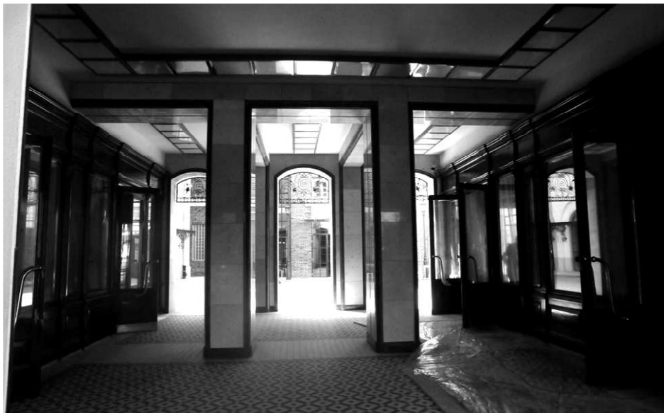
Rys.4. Zamieniony ustrój nośny ścianowy na ustrój szkieletowy (Hotel Saki w Warszawie)
