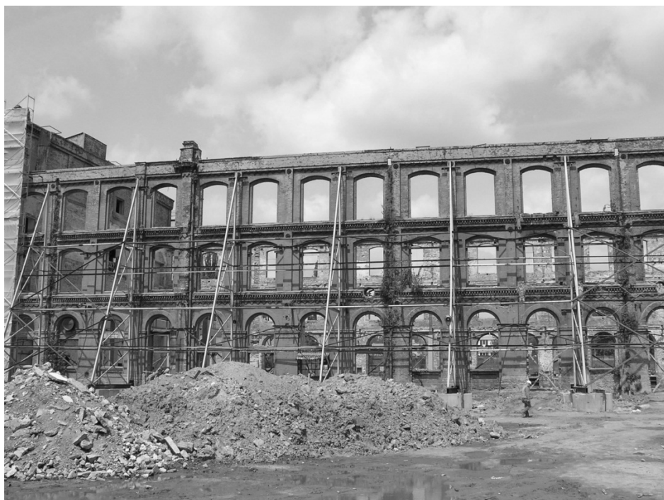
Rys.2. Usztywnienie ściany pozbawionej stropów przyporami (Manuaktura w Łodzi)
