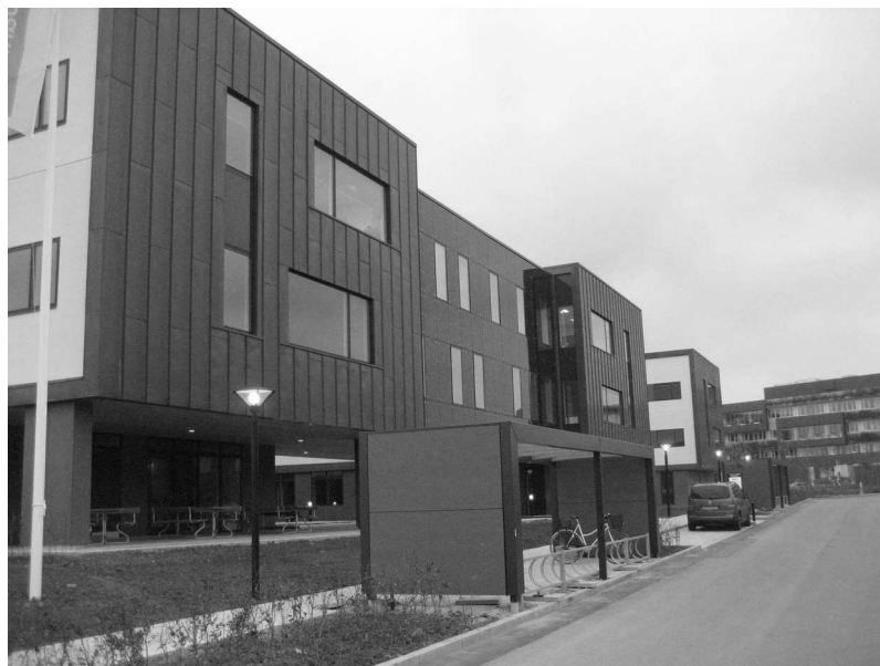
Rys. 8. Budynek biurowy, poddany trzem systemom certyfikacji, Company house w Danii [13]
