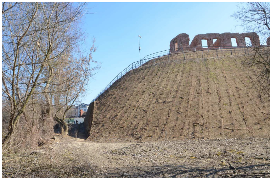
Rys. 7. Widok ściany oporowej kaszycowej i ruin zamku w Sochaczewie
