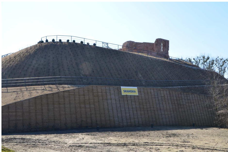
Rys. 9. Widok ściany oporowej kaszycowej i ruin zamku w Sochaczewie
