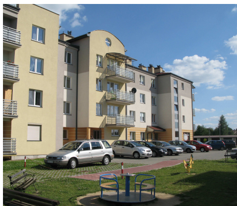
Rys. 2. Obszar II – zabudowa wielorodzinna blokowa w Boguchwale (fot. własna)
