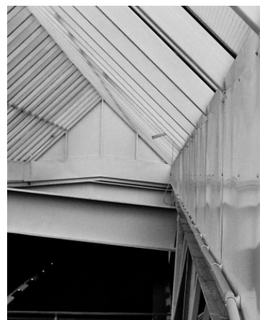
Rys. 2. Widok świetlika od wnętrza hali
