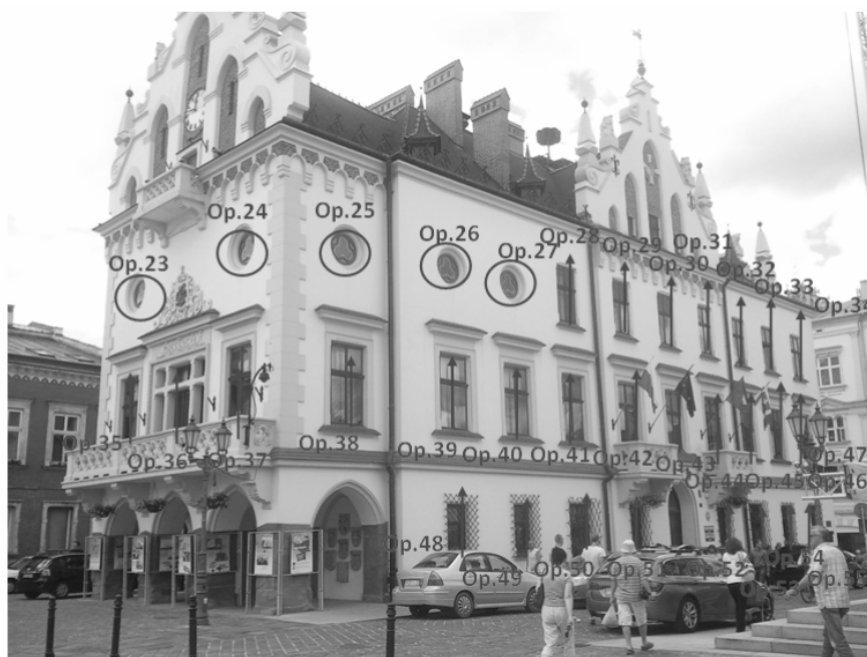
Rys. 4. Fragment instalacji iluminacyjnej, rozlokowanej na elewacjach wschodniej i północnej Ratusza Rzeszowskiego [1]
