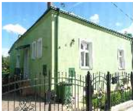
Il.20. Zdjęcia domu od strony zachodniej Fig.20. Western elevation of the house
