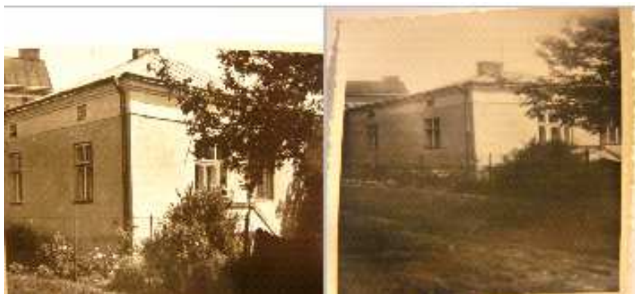
Il.19. Zdjęcia domu z lat 60 tych zbiory własne
