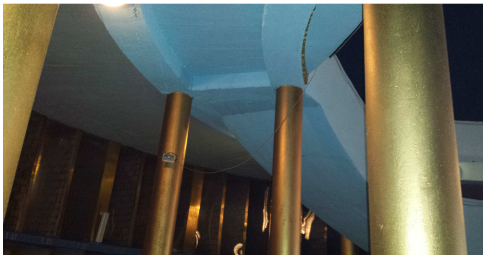
Fot.4. Widoczny fragment podciągu i słupy o średnicy \phi 30 cm podpierające płytę balkonową kondygnacji nad parterem oraz podpierające schody wachlarzowe jednobiegowe.
