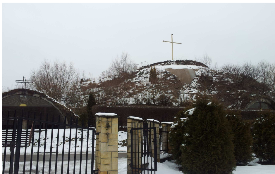
Fot. 6. Fragment kopuły kurhanu z widocznym obsunięciem się gruntu poniżej krzyża (zima 2012). Widok od strony wejścia do budowli. Po lewej stronie kurhanu widoczny ołtarz polowy.
