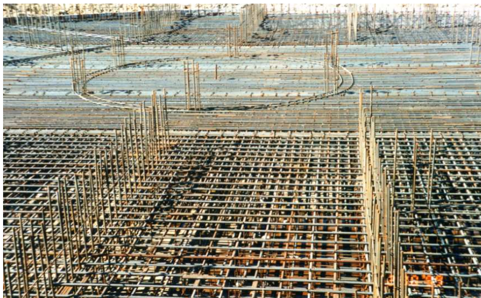
Fot.3. Fragment zbrojenia płyty fundamentowej prętami średnicy \phi 32 co 25cm ze stali klasy A - II żebrowanej oraz zbrojenie pod ściany krypt prętami pionowymi \phi 20 co 25cm i słupów 6szt. \phi 20 cm /fotografia.*)
