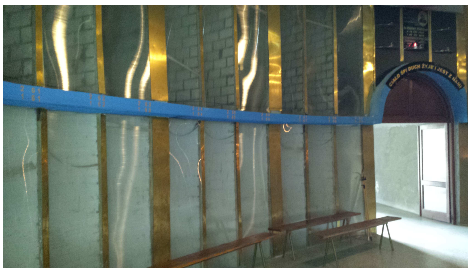
Fot.1. Fragment rozmieszczenia krypt na ścianie kaplicy na kondygnacji pierwszej. W górnym rzędzie widoczne krypty w stanie surowym, w dolnym rzędzie krypty przygotowane do zamknięcia płytami betonowymi.
