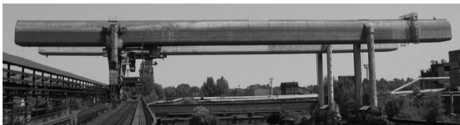
Rys. 1. Most przeładunkowy o konstrukcji powłokowej
