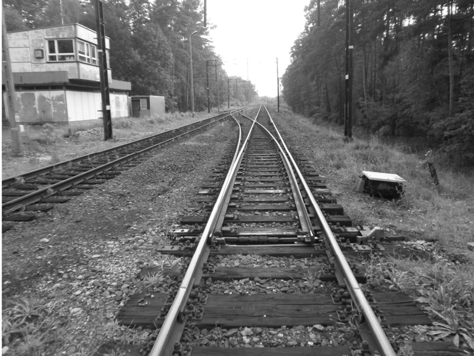
Rys. 2. Rozjazd zwyczajny nr 1 typu S60 – 1:9 – 300 (fotografia własna)
